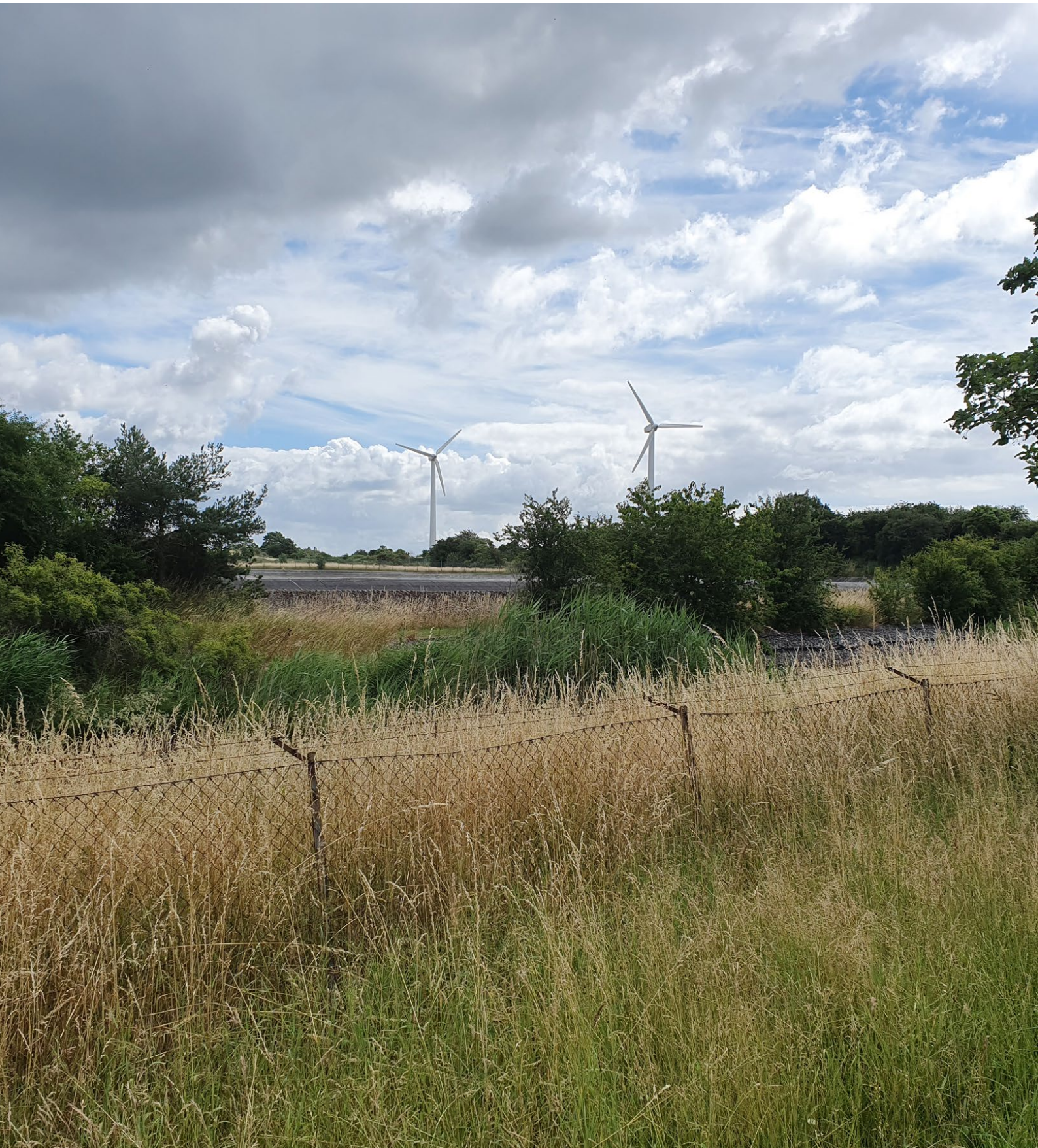
Billede fra Kystagerparken i Hvidovre, der viser indkig til planområdet fra stien langs Harrestrup Å. På den modsatte side af Harrestrup Å ses renselanlæggets bassiner og de to Vestas V27 møller, der står i området hvor det planlagte anlæg ønskes opført, ses i baggrunden.
