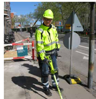
HOFOR-medarbejder leder efter stophaner på Østerbro - også i en Corona-tid og med de restriktioner, der var gældende på det tidspunkt.
