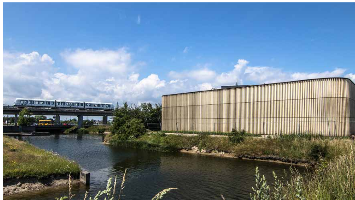
Fjernkølingscentral i Ørestaden.
