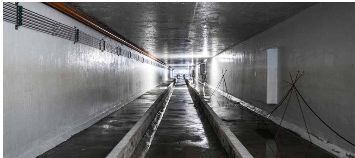
Tunnelen under Lyngbyvejen er blevet ombygget til et skybrudsbassin, der kan tilbageholde 700 m 3 skybrudsvand.
