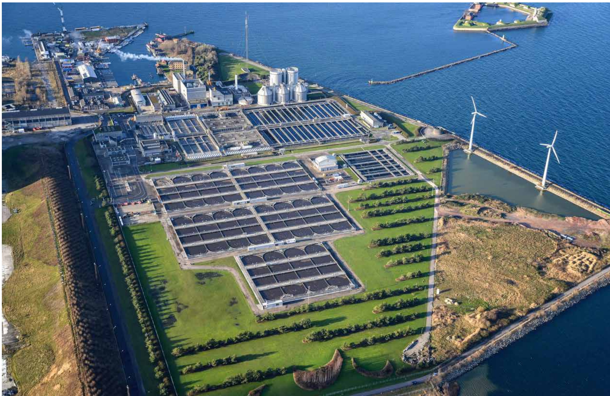
Renseanlægget Lynetten set fra luften.
