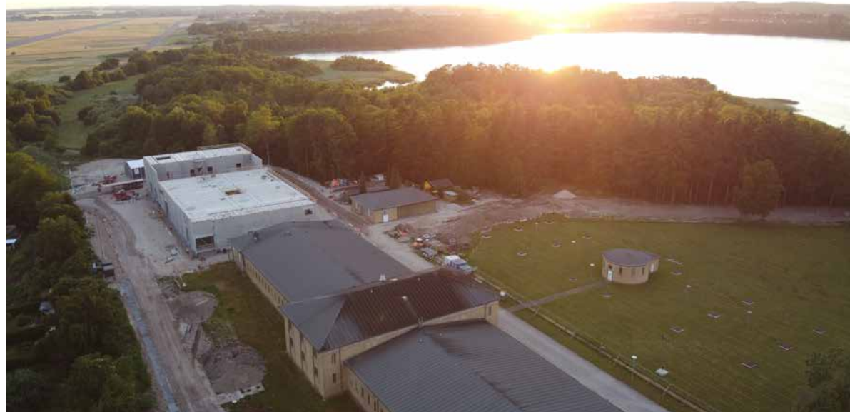
Værket ved Sønderø gennemgår en stor ombygning og renovering. Bygningsarbejdet følger tidsplan, således at værket kan være med til at levere blødere vand til kunderne.
