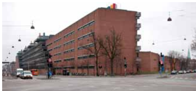
Lokalplanområdet set fra krydset ved Tagensvej og Nørre Allé. Området domineres af det eksisterende Panum-kompleks.
