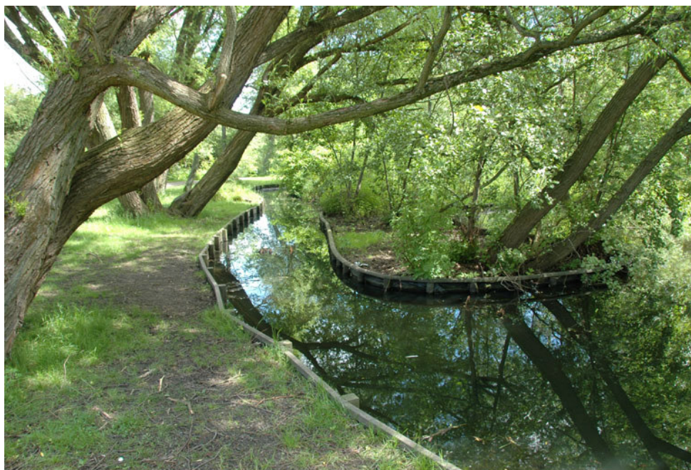
Figur 6-64 Erosionssikring langs kanalerne i Degnemosen begrænser den naturlige overgang mellem land og vand.
