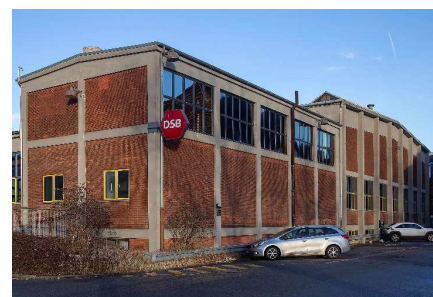
19. og 20. Værksted og Eftersynshal.
