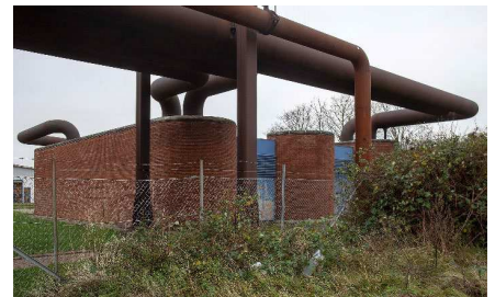
26. Teknisk anlæg ved Vasbygade.
