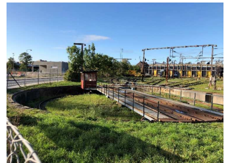
Drejeskiveanlægget i dag. Drejeskiven kommer til at indgå i det nye byrum.
