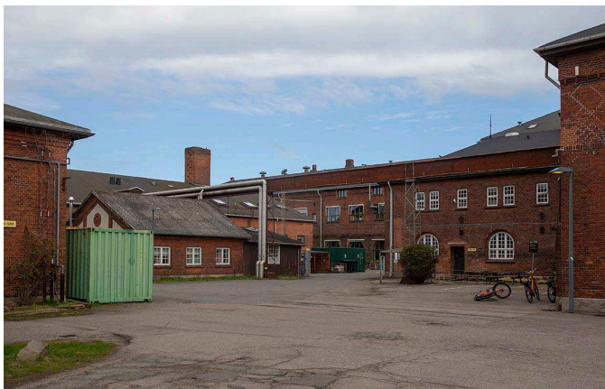
Centralværkstederne danner i kraft af deres arkitektur og farveholdning en helhed trods stor detaljerings- og skalamæssig variation.
