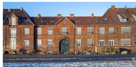
23. Kontor- og administrationsbygning.
