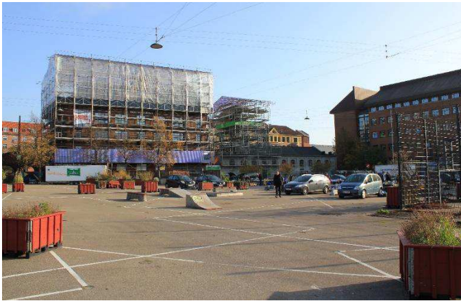
Den sydlige del af Toftegårds Plads set fra hjørnet ved Gammel Køge Landevej og Vigerslev Allé. I baggrunden Valby Kulturhus, der er under renovering samt ATP's store kontorhus, der bl.a. rummer lejemål til Movia
