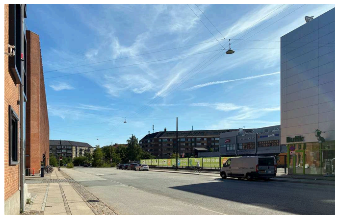
Kig fra Sejrogade ned mod Skt. Kjelds Plads og den nordlige del af lokalplanområdet. Her ses karré kvarterets kant op imod pladsen og Bryggervangen i baggrunden.
