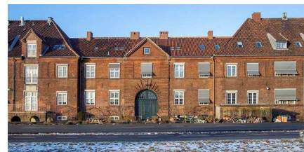
23. Kontor- og administrationsbygning.
