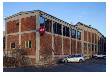
19. og 20. Værksted og Eftersynshal.
