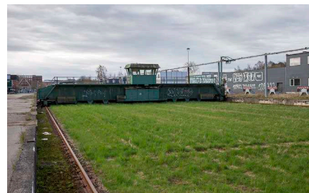
29. Skydebroanlæg, broer, førerhus og spor.
