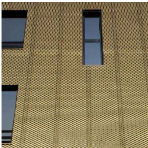
Figur 7-6 Eksempel på perforeret stålfacade med absorberende bagved.
