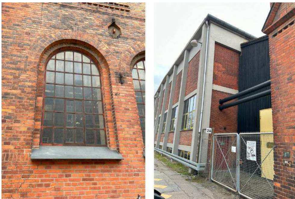
Figur 5-112 Tv. Facadedetalje og th. sammenbygning med Eftersynshallen. Foto COWI.
