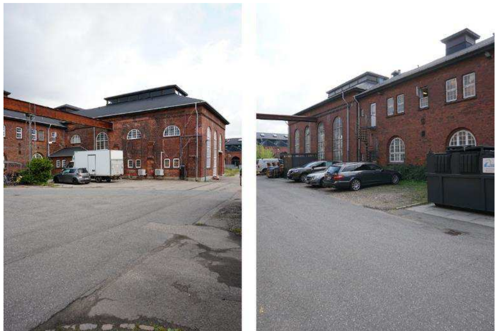
Figur 5-65 Tv. Kraftcentralen set fra sydvest. Th. Kraftcentralen set fra nordvest. Foto Cobe.
