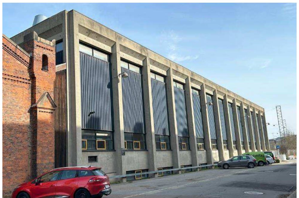
Figur 5-118 Ny eftersynshal set fra syd. Foto COWI.
