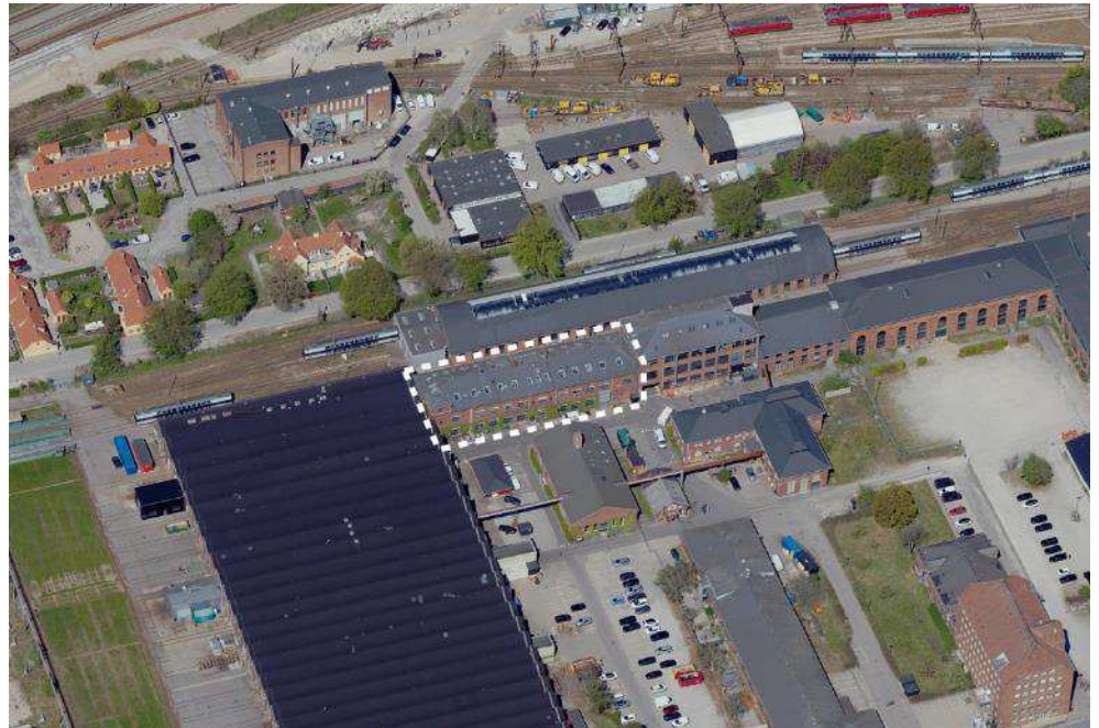
Figur 5-34 El- og sadelmagerværkstedet ligger med direkte adgang til Vognværkstedet mod vest og Nyt elektrisk værksted mod øst. Illustration COWI, 2024.
