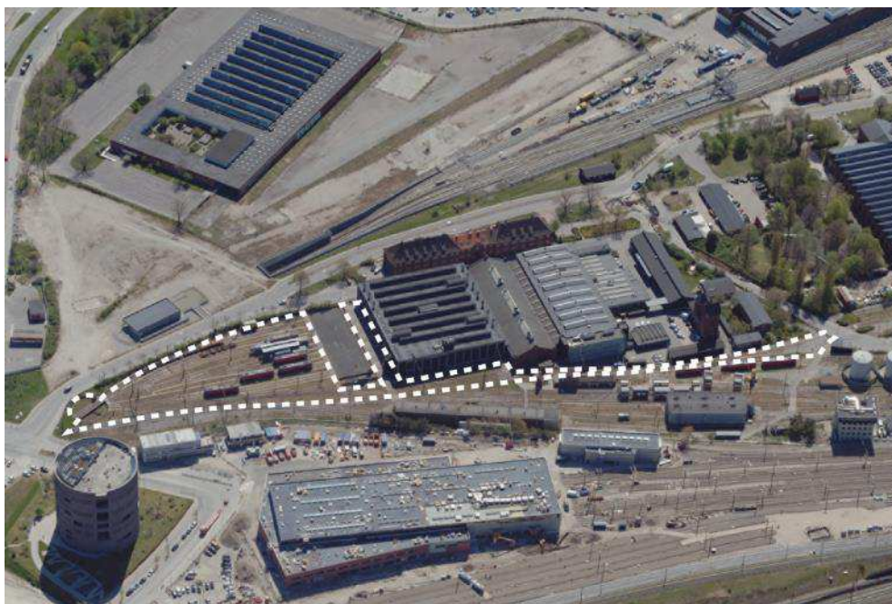
Figur 6-6 Udpegning af bevaringsværdige spor omkring Godsbanens remise er markeret med en lys farve. Illustration COWI.
