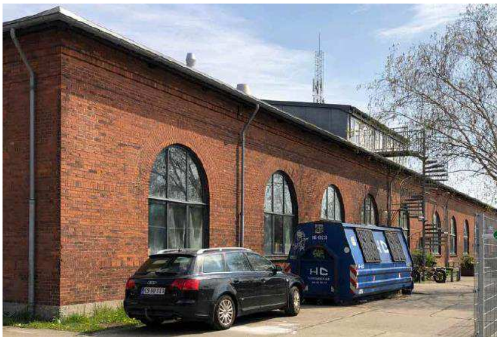
Figur 5-69 Blanketlageret set fra vest. Foto Cobe.
