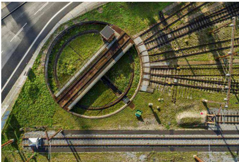
Figur 6-14 Drejeskiven set fra luften. Foto Cobe.
