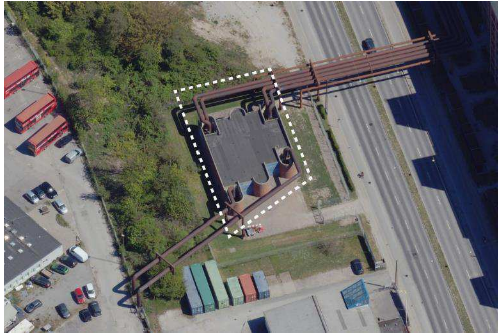
Figur 6-3 Teknisk anlæg ved Vasbygade. Foto COWI.
