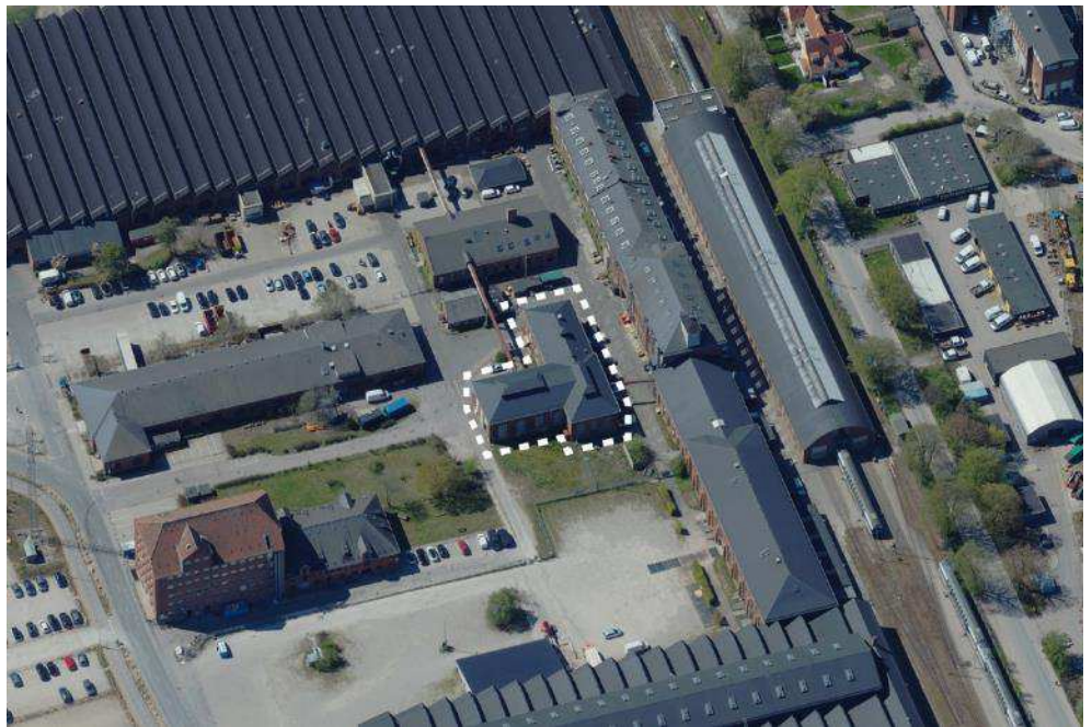
Figur 5-63 Kraftcentralen ligger inde i Centralværkstedets gårdrum og er forbundet med rør til de øvrige værksteder. Illustration COWI.
