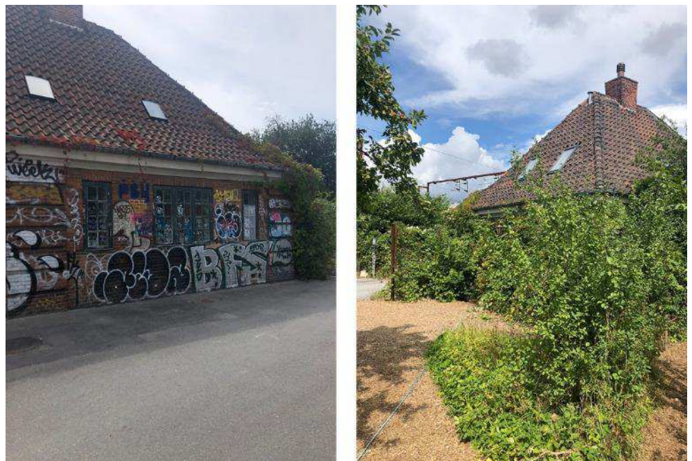
Figur 5-5 Foto th. Portbygning set fra nord for enden af Otto Bussesses Vej. Foto tv. af Portbygningen set fra Bivejen. Foto Cobe 2023.
