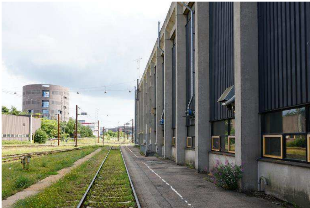
Figur 5-120 Ny eftersynshal set langs den nordlige facade mod øst. Foto Cobe.
