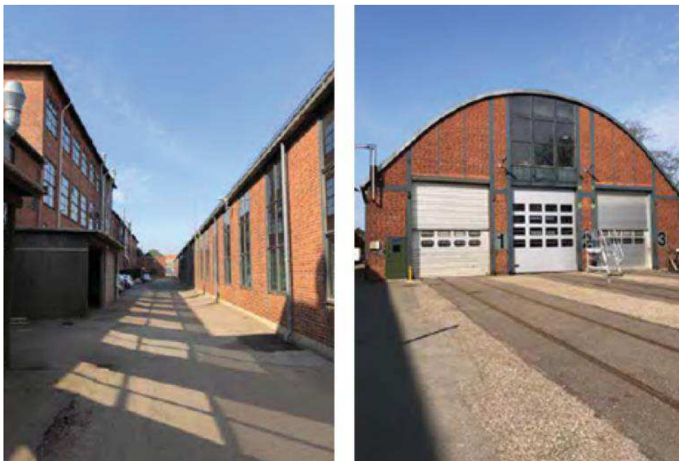
Figur 5-30 Lyntogsløftehallen. Til venstre ses gaderummet mellem Lyntogsløftehallen og 'stangen' i Centralværkstedet. Til højre ses den østlige gavl. Foto Cobe.
