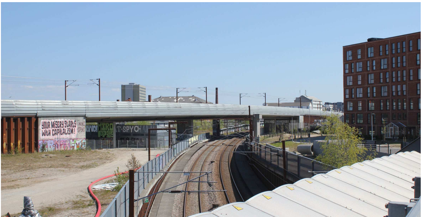
Den østligste del af lokalplanområdet til venstre, Ringstedbanen midt i billedet og nybyggeri på Grønttorvsområdet til højre.
