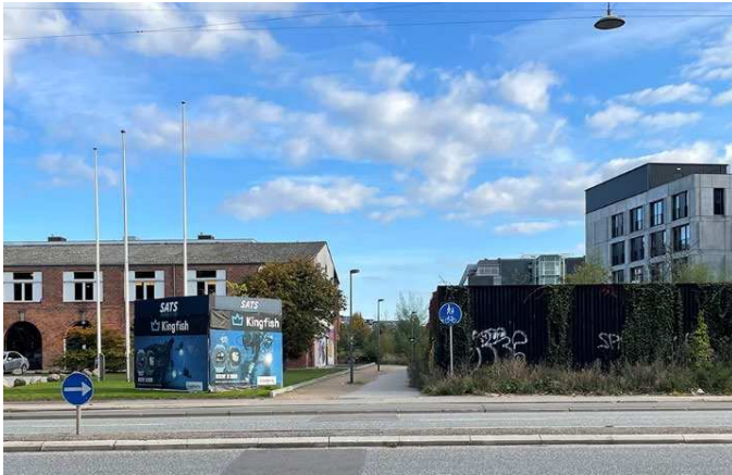
Billede fra stedet - indgangen til 'Den grønne Kile' set fra vestsiden af Scandiagade. Den eksisterende bygning Scandiagade 13-15 ses til venstre i billedet.
