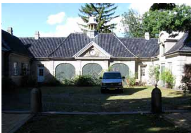
Garageanlægget "vognporten", Strandpromenaden 33, er ligesom villaen registreret med høj bevaringsværdi (skalatrin 3).
