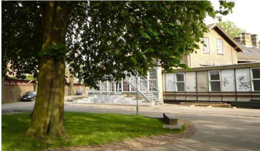
Foto 4 Bygningen, der ses i baggrunden (jf. bygning nr. 7 figur 3.9), er bevaringsværdig af høj værdi, og vil blive fjernet. Barakken der ses i baggrunden til venstre fjernes også, men denne er ikke vurderet bevaringsværdig (bygning nr. 9 figur 3.9).
