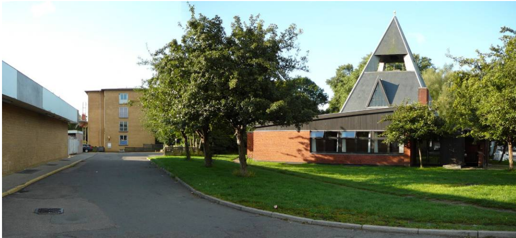
Foto 1 Lundehus Kirke ses til højre i billedet. Bygningerne til venstre i billedet risikerer at blive fjernet, afhængig af valg af tilkørselsrampe.
