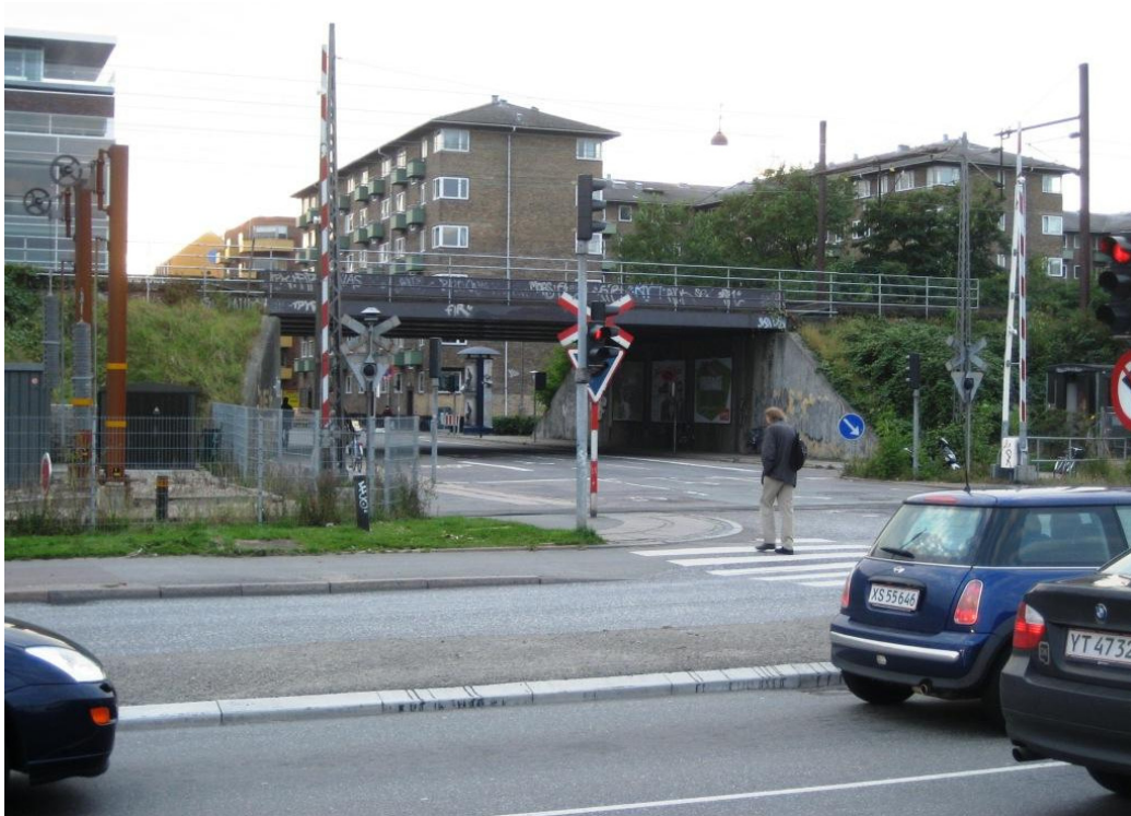
Figur 4.5; Foto af vej/tog krydsning ved Århusgade og Kalkbrænderihavnsgade
