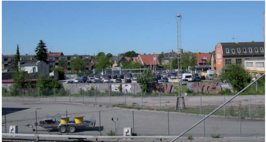
Et kig ud over området set fra banen. De ubenyttede bygninger ses til venstre og højre i billedet.
