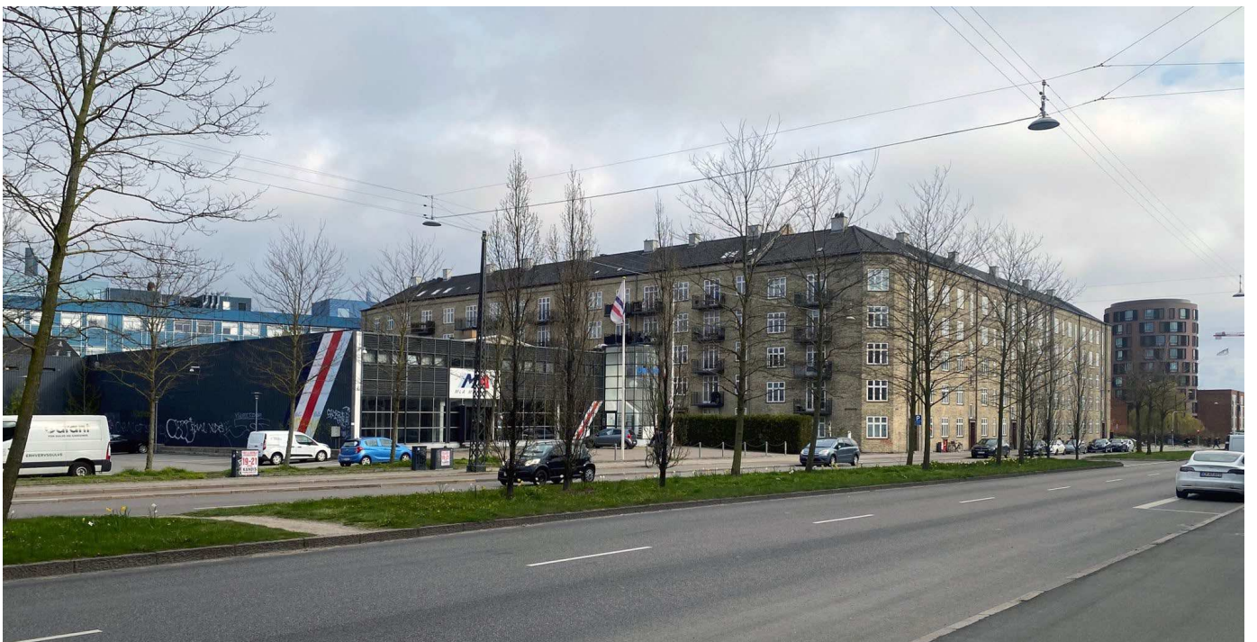
Lokalplanområdet set fra Jagtvej. Forrest ses eksisterende bebyggelse, der forudsættes nedrevet. I baggrunden ses andelsboligforeningen A/B Parkalléen.
