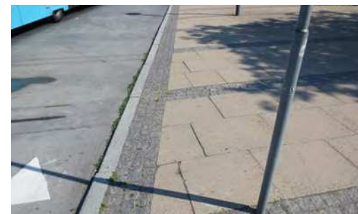
4. Eksisterende belægning ved Den Trafikale Plads
