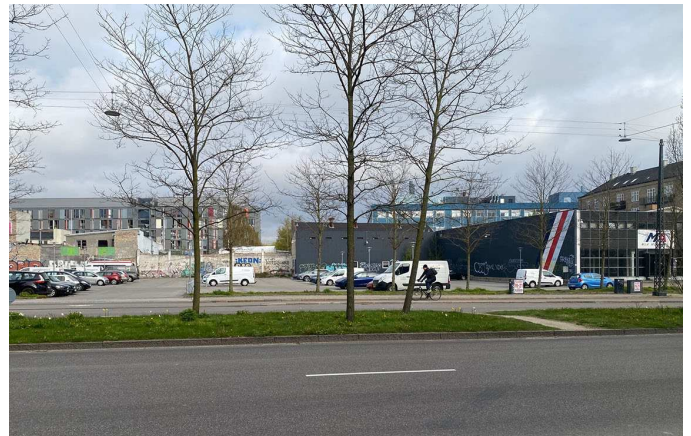
Kig fra Jagtvej. I baggrunden ses IAK-kollegiet. Til højre i billedet ses lokalplanområdet og bebyggelse, der forudsættes nedrevet.
