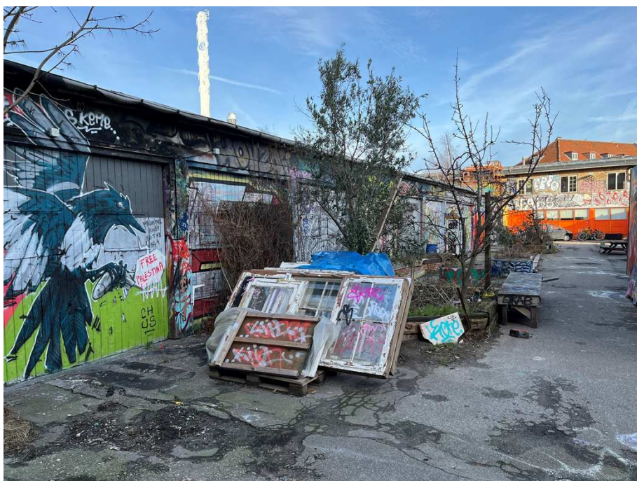
Bygning V, Garager – Set fra den vestlige del af området.
