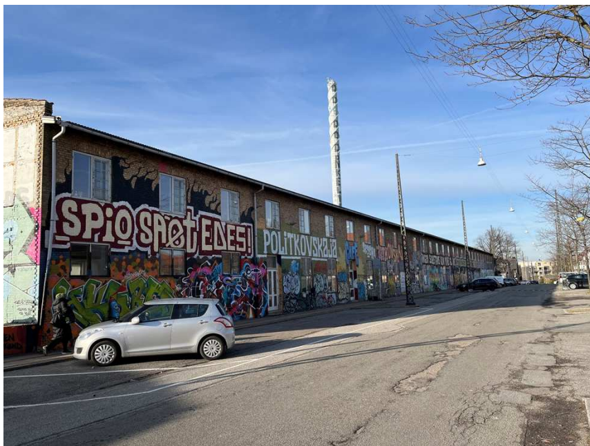
Bygning VII – Set fra Ragnhildgade.
