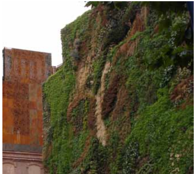
Eksempel på varmeisolerende og begrønnet gavl.
