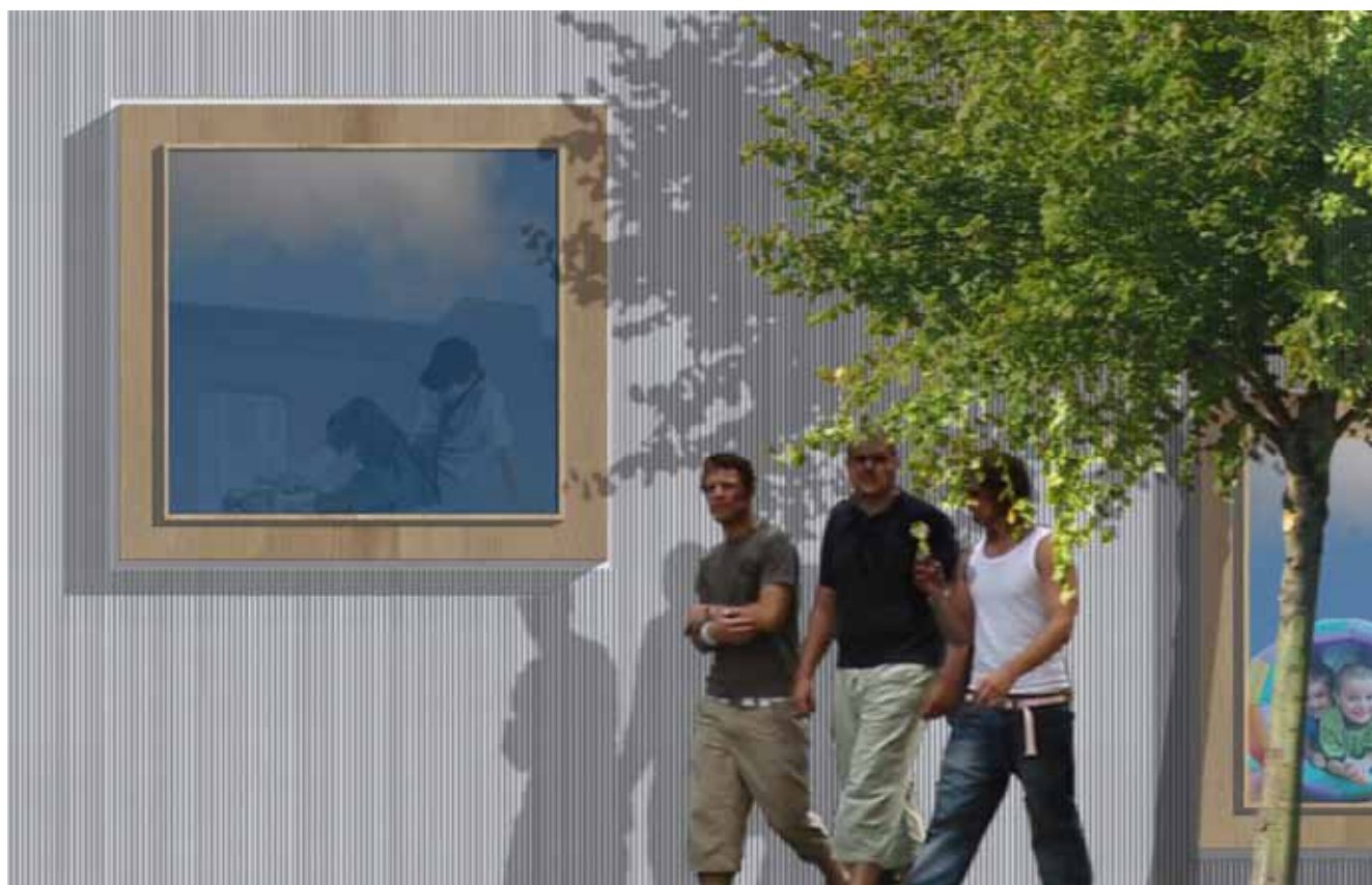
Facadeudsnit der viser materialeholdningen på børnekulturhuset.
