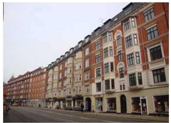
Amagerbrogade 117-127 er opført i årene 1904-1923. Amagerbrogade 123 er et infillbyggeri fra 1993.
