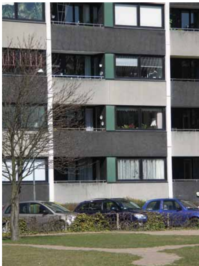
Udsnit af facade mod gård
