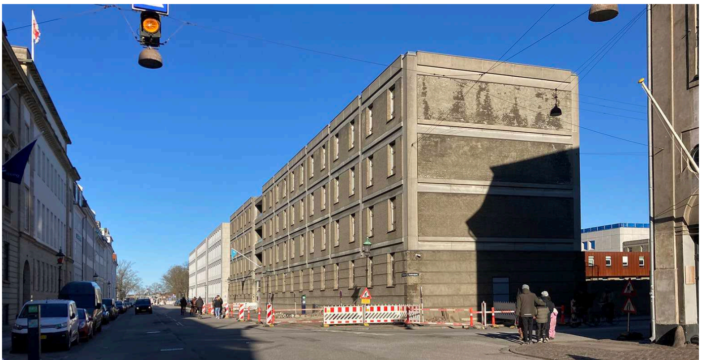
Lokalplanområdet set fra Amaliegade mod hjørnet ved Toldbodgade
