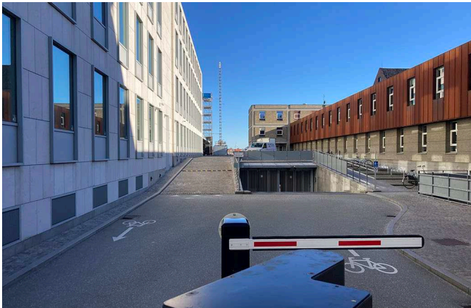
Passage mellem Amaliegade 44 og Esplanaden 50 med nedkørsel til p-kælder og stiforbindelse til havnepromenaden ved Inderhavnen.
