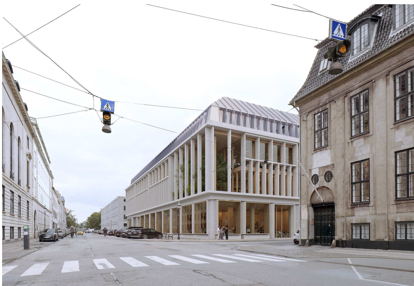
Nyt hovedsæde set fra hjørnet af Amaliegade og Toldbodgade. Visualisering, der viser et eksempel på nybyggeri i overensstemmelse med den højst mulige højde i lokalplanen. Højden på tre etager er 16,4 m, ved gesimsen ved tredje etage er højden 15,6 m, og højden på fire etager inkl. tage er 23,1 m. Illustration: Dorte Mandrup A/S.
