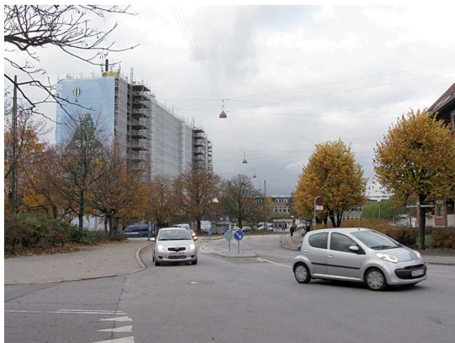
Kollektivhuset ved Hans Knudsens Plads
