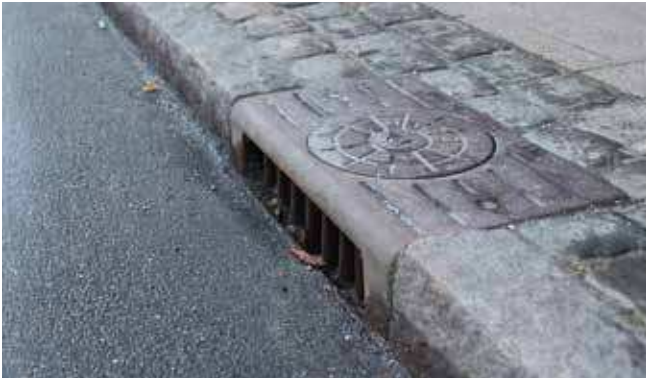
Sideindløbsbrønd på Stormgade
