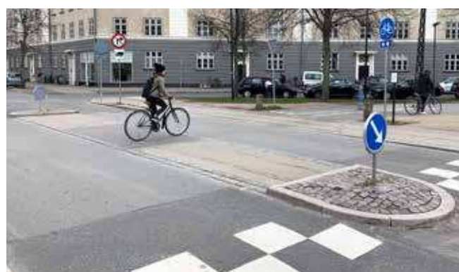
Cykelstikrydsning med midterhelle, Nørrebrodden/Stefansgade
