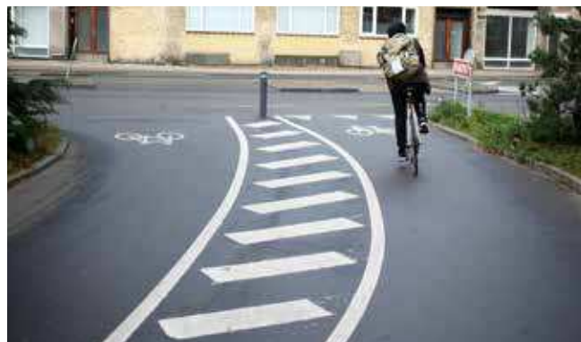
Dobbeltrettet cykelsti med steler og spærreflade ved Sankt Kjelds Plads
