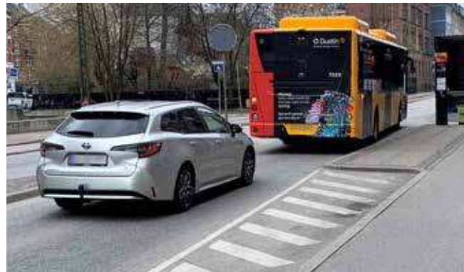
Fremrykket busstoppested på Enghavevej
