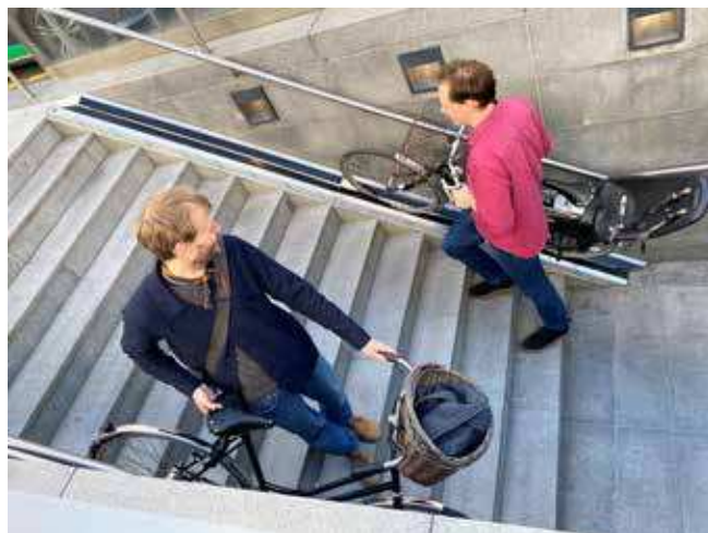
Cykelsliske forsøg ved Amagerbro Station
