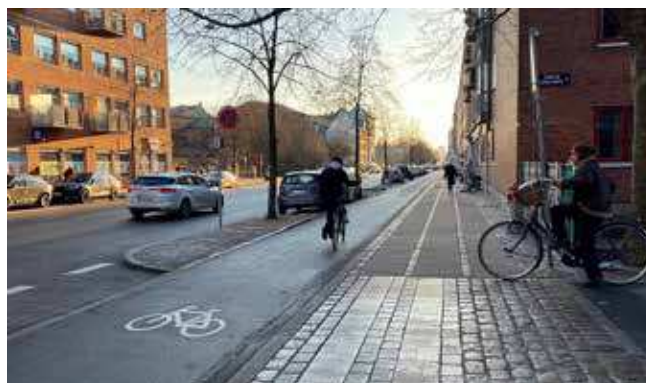
Overkørsel og gennemført cykelsti på Jagtvej
