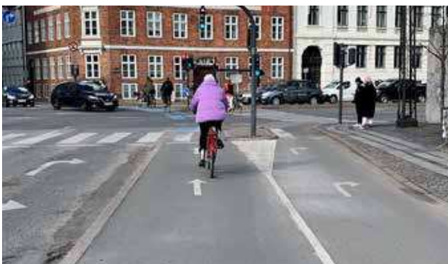
Fremført cykelsti med separat regulering, Havnegade/Holmens Kanal
