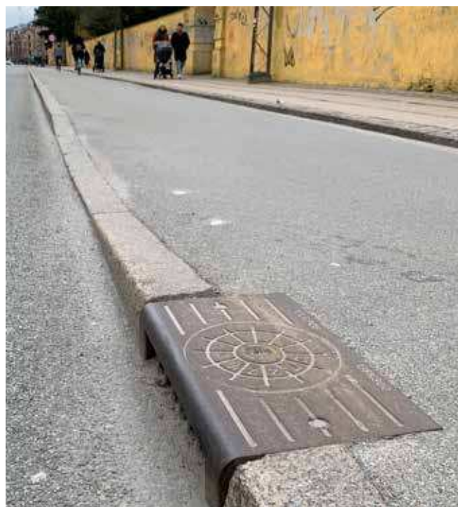
Dykket kantsten og sideindløbsbrønd på Nørrebrogade
