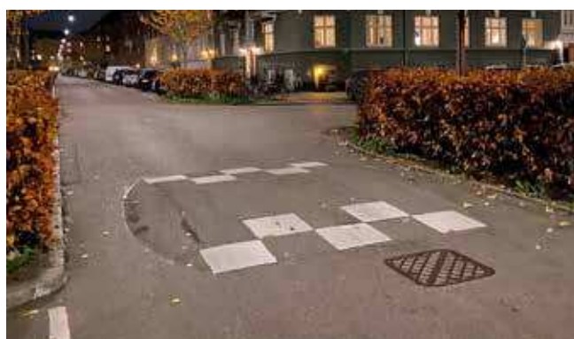
Bump og indsnævring på Julius Bloms gade
