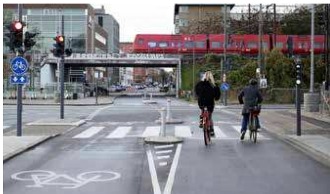
Dobbeltrettet cykelsti og støttehelle afmærket med spærreflade på Århusgade
