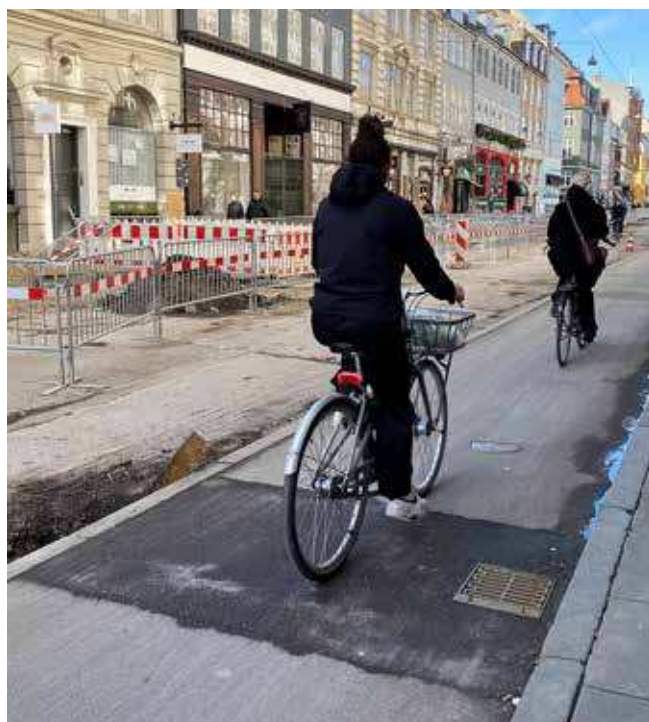
Reparation på hele cykelstibredden på Gothersgade
