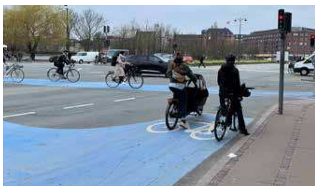
Venteområde til venstresvingende cyklister med blåt cykelfelt, Gyldenløvesgade/Nørre Søgade
