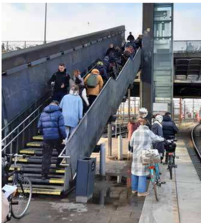
Trappe og elevator ved Dybbølsbro st., hvor kapaciteten i myldretiden er en udfordring for både fodgængere og cyklister
