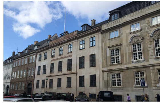
Amaliegade 23-25; Mellembygning, Gedefacade
