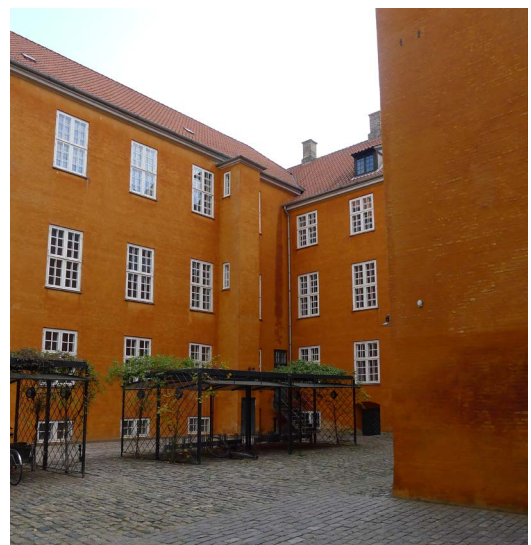
Amaliegade 23-25; Nr. 25, Sidehus 1 og Gårdfacaden på forhus
