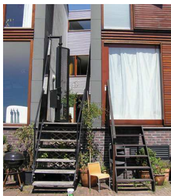
Boliger i stueetagen med trapper. Reference: Amsterdam.
