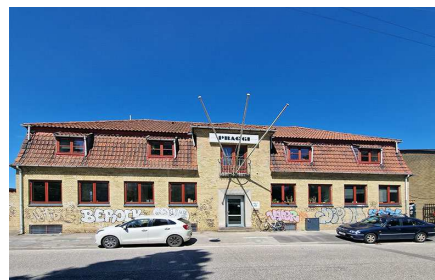
Hovedbygningen på Siljangade 61, der foreslås udpeget som bevaringsværdig.
