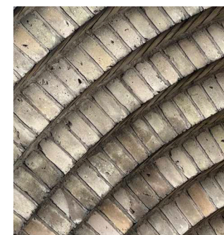
Tegldetalje ved trappe
