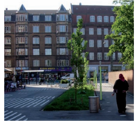
Det ny Prags Boulevard, Amagerbro.
