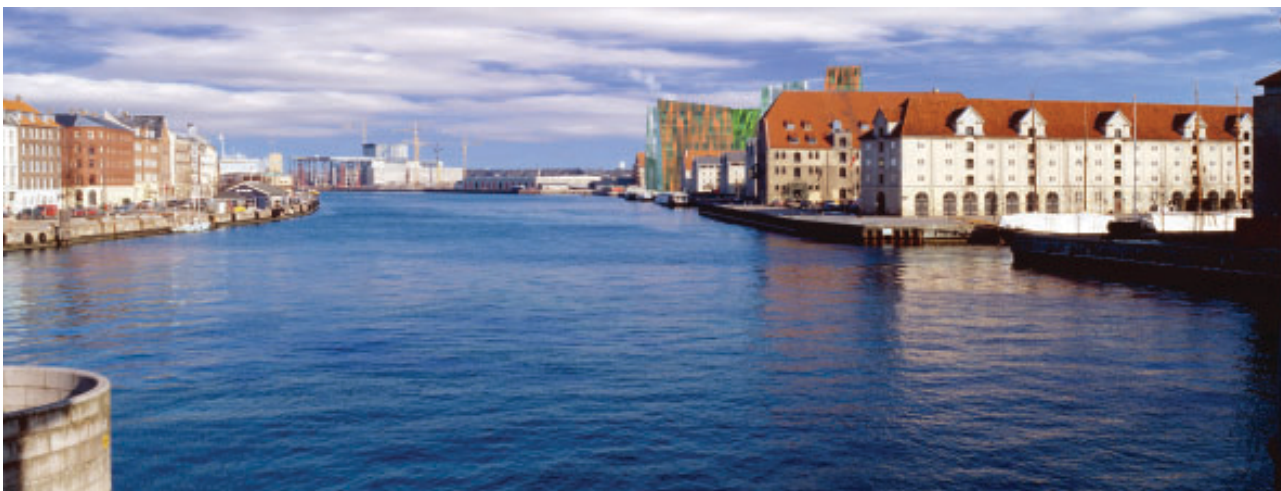
Et kig til bebyggelsen set fra Knippels Bro. Gavlene er det markante arkitektoniske motiv, hvor de nye bygninger er i dialog med de eksisterende.
