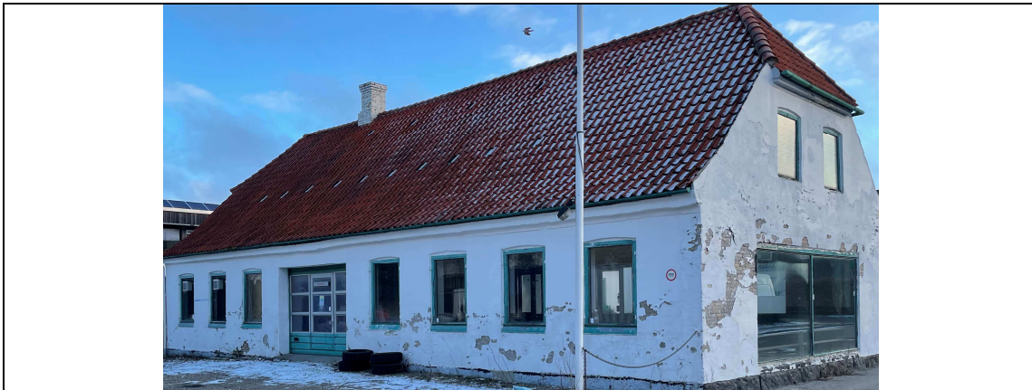
Billede 1 – Bygning 1 vestfacade
