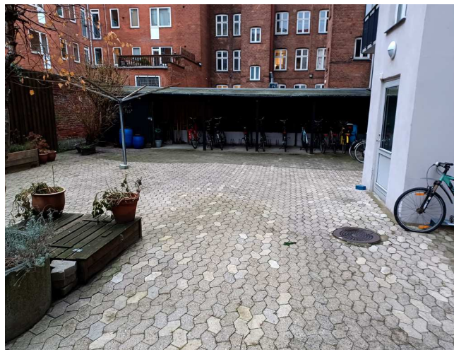
Eksisterende forhold Foto: MASU Planning
