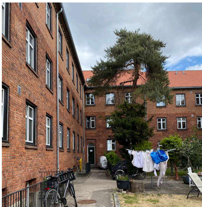
Eksisterende forhold Foto: Københavns Kommune
