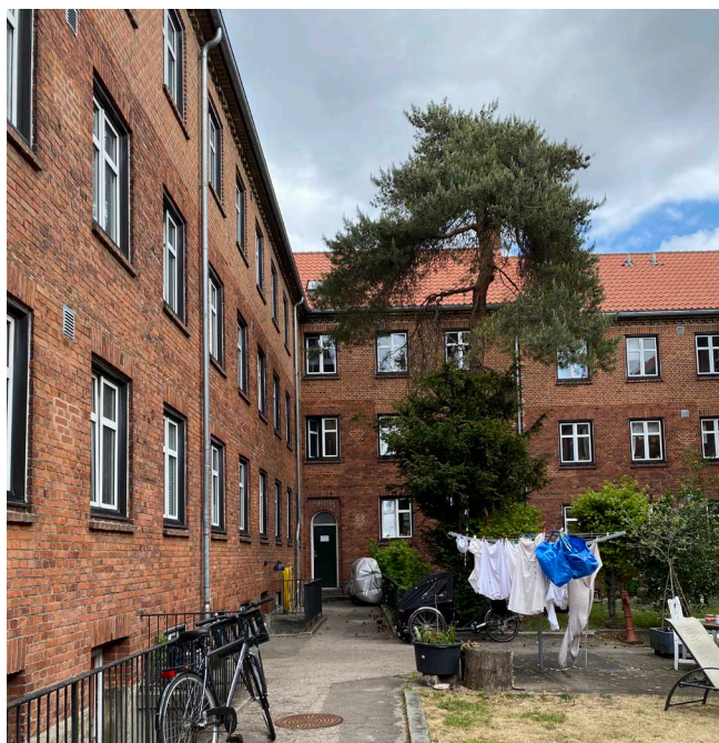
Eksisterende forhold Foto: Københavns Kommune
