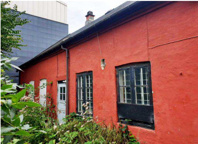
Forhusets bagfacade set fra gårdrummet mellem bygningerne på Øresundsvej 21.
