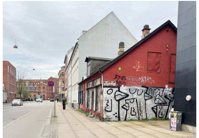
Forhuset set i retning mod Amagerbrogade og i relation til gadens skala.
