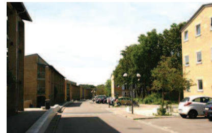
View fra Arkaderne set mod vest. Facader med hhv. kolonnade og gavle. Bygningernes placering fremhæver vejens krumning.
