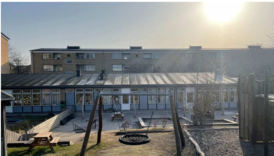
Daginstitution ved Bygårdstræde set fra vest. Daginstitutionen muliggøres nedrevet. I stedet opføres en ny, større daginstitution.
