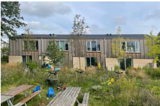
Nye rækkehuse ved Skolesiden set fra syd.
