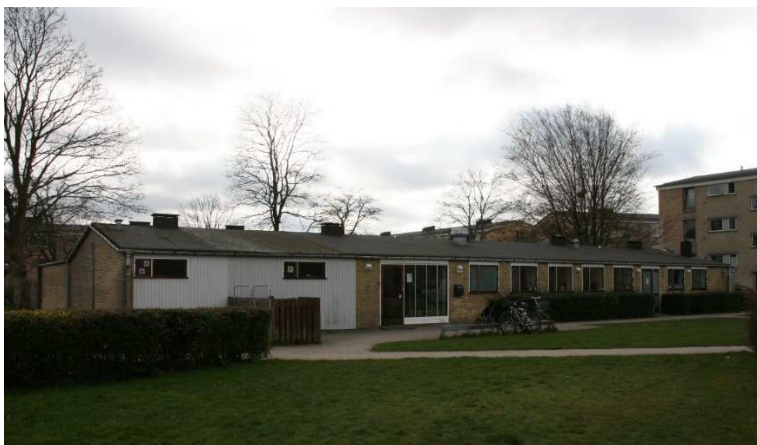
Den fritliggende fløj set fra nord
