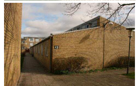
Institutionsbygninger i 1 etage og med forskudte tage
