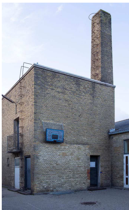
Engvej 143 - Kedelhus opført i 1961.
