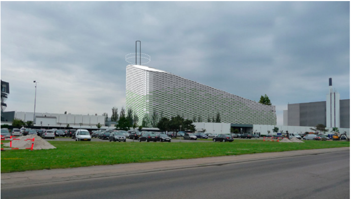
3-D visualisering af den nye Amagerforbrænding set fra Kraftværksvej. Visualiseringen viser en skorstenshøjde på 125 m og en bygningshøjde på 90 m.
