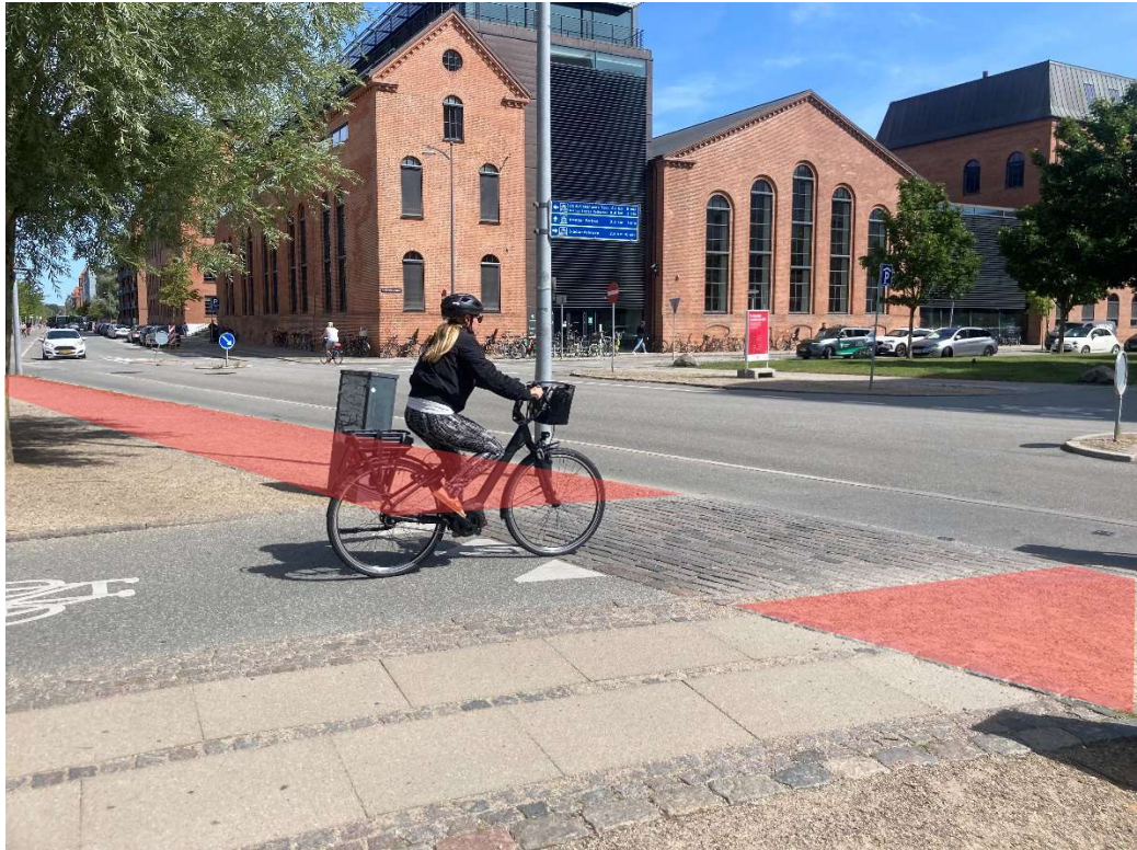
Figur 55: Foto af den eksisterende stis tilslutning til Islands Brygge. Grusarealerne der med fordel kan etableres med fortovsfliser er markeret med rød flade.
