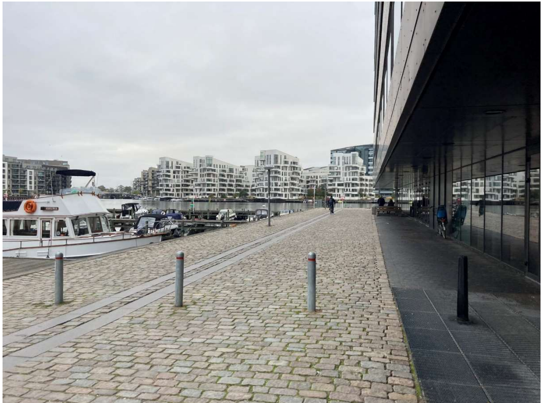
Figur 54: Der kan eventuelt opsættes bomme der skal nudge cyklisterne til at følge den korrekte vej via cykelstien på Islands Brygge.
