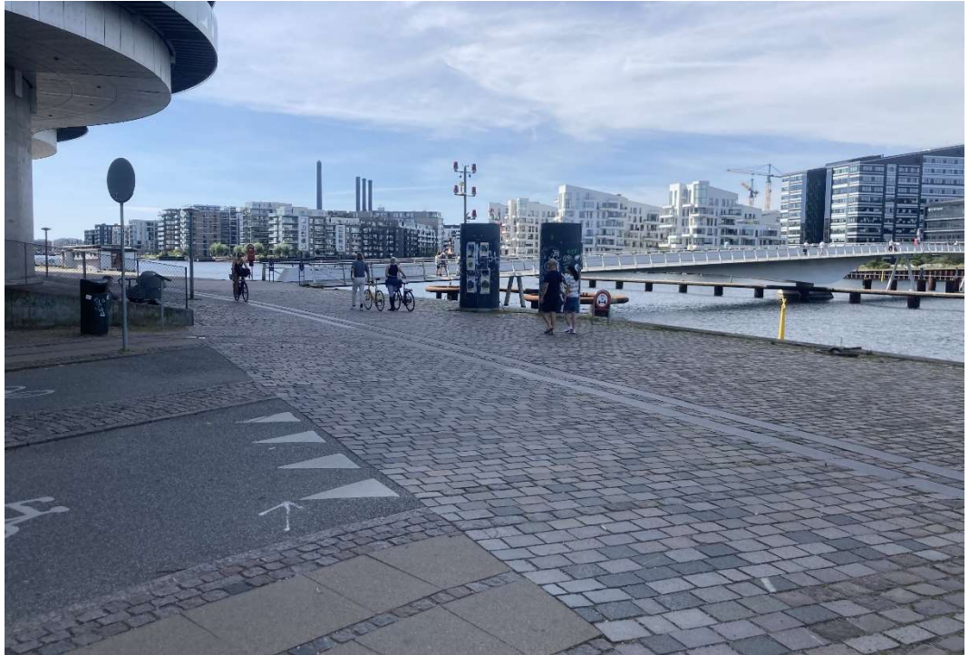
Figur 3: Foto af belægningen ved Bryggebroens landing.
