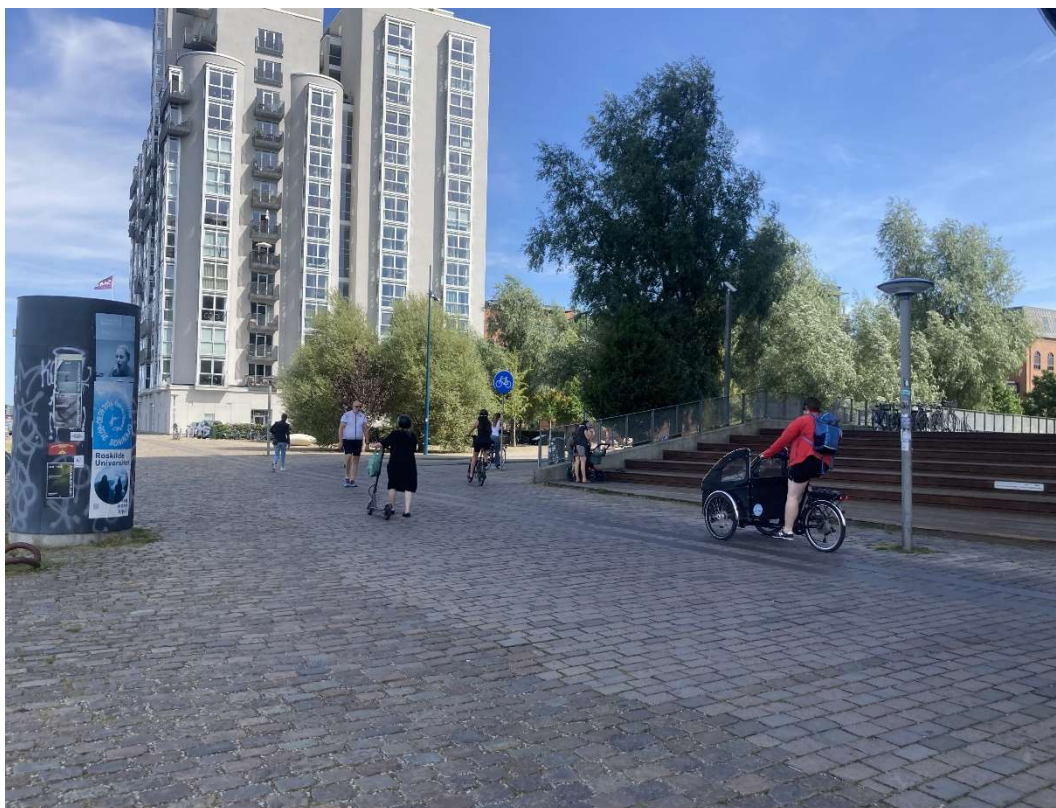
Figur 5: Foto af belægningen på Bryggebroens landing. På billedet ses forskellen på kløvede brosten og sandede og jetbrændte brosten.
