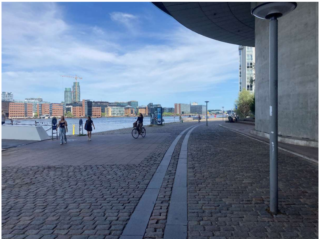
Figur 4: Foto af belægningen på Bryggebroens landing.
