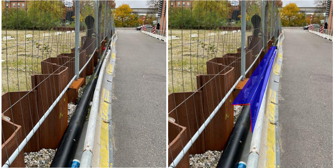
Foto 3. Ledning på Fiskerihavsgade
