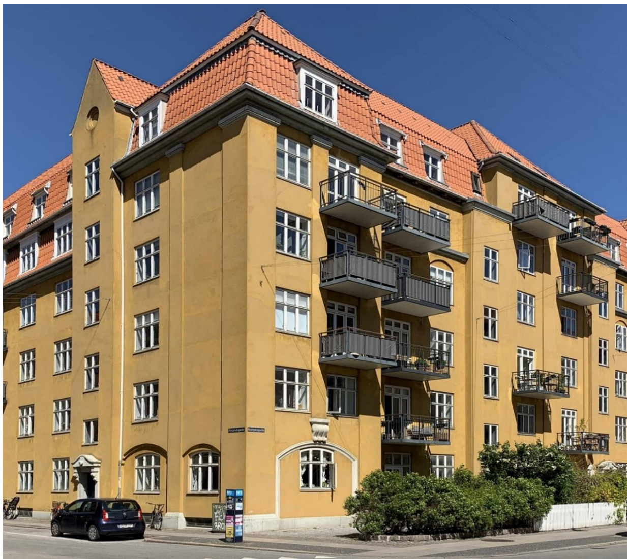
Finlandsgade / Norgesgade (foto: Bygningsfornyelsen)
