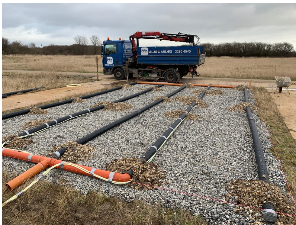
Figur 3.2 Testfelt 2 under etablering. Som i Figur 3.1 er drænledningerne sorte, forbindelsesrørene orange, mens de hvide slanger er slanger til målepunkterne.
