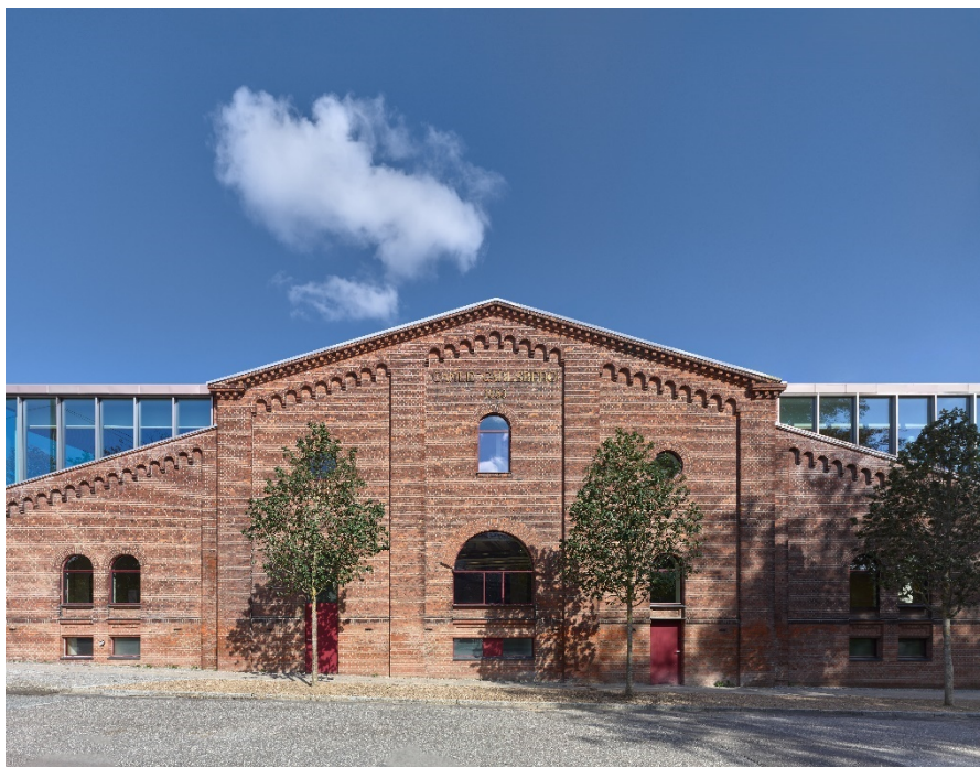
Rød lagerbygningens vestgavl.
