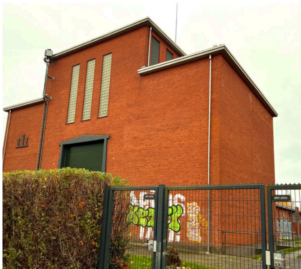
Transformestationen i Brønshøj blev opført i 1941 for at forsyne de store nye boligkvarterer i bydelen med strøm. Stationen er et typisk eksempel på Københavns Kommunes mange bygninger, der indgår i storbyens forsyning. Som del af et værdifuldt kulturmiljø, kommer bygningen og dens historie til sin ret som et vigtigt kulturspor, der vidner om Københavns historie og udviklingstræk.
