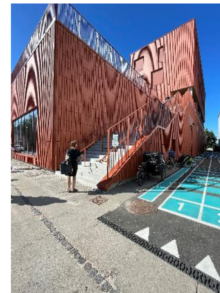
Fordelingstrappe og løbebane på Nordøstamager Skole
